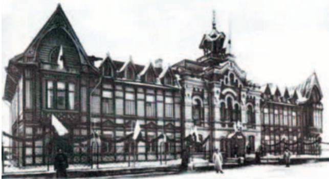
Лахтинская улица, № 12. Фасад
